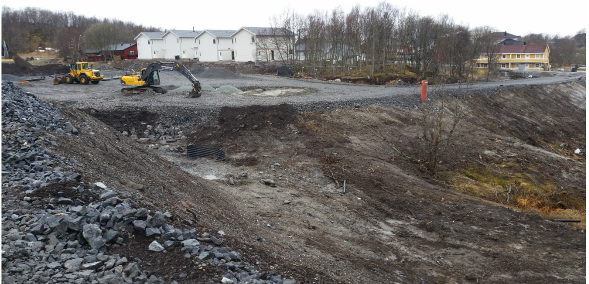
Parkeringsplass: Arbeidet med parkeringsplassen ved Tverlandet holdeplass fortsetter. Foto: Ronny Pedersen, Jernbaneverket.
