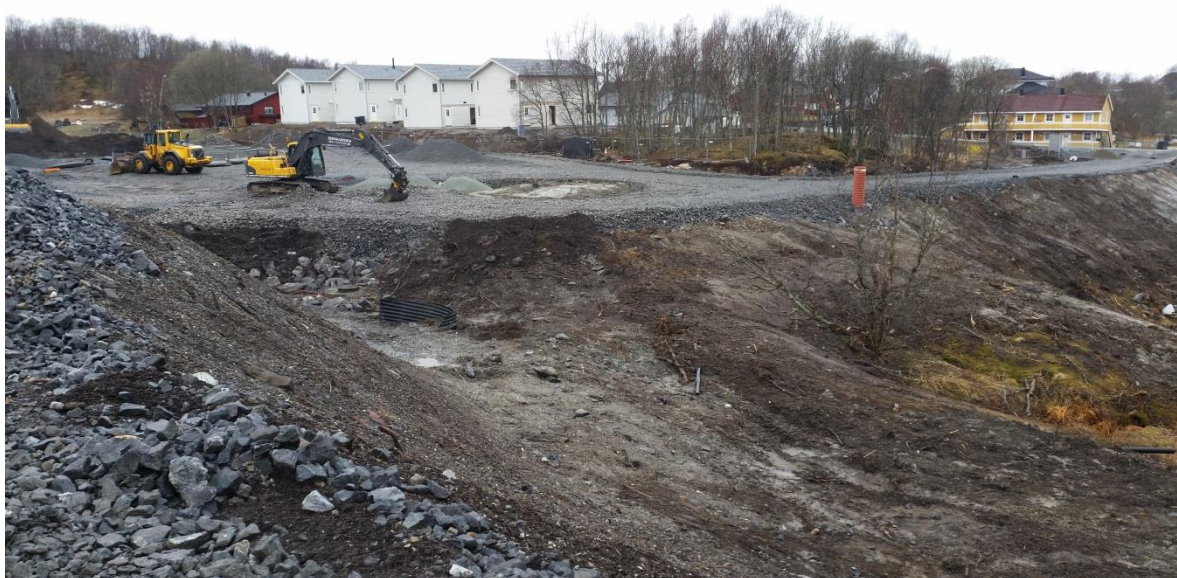
Parkeringsplass: Arbeidet med parkeringsplassen ved Tverlandet holdeplass fortsetter. Foto: Ronny Pedersen, Jernbaneverket.
