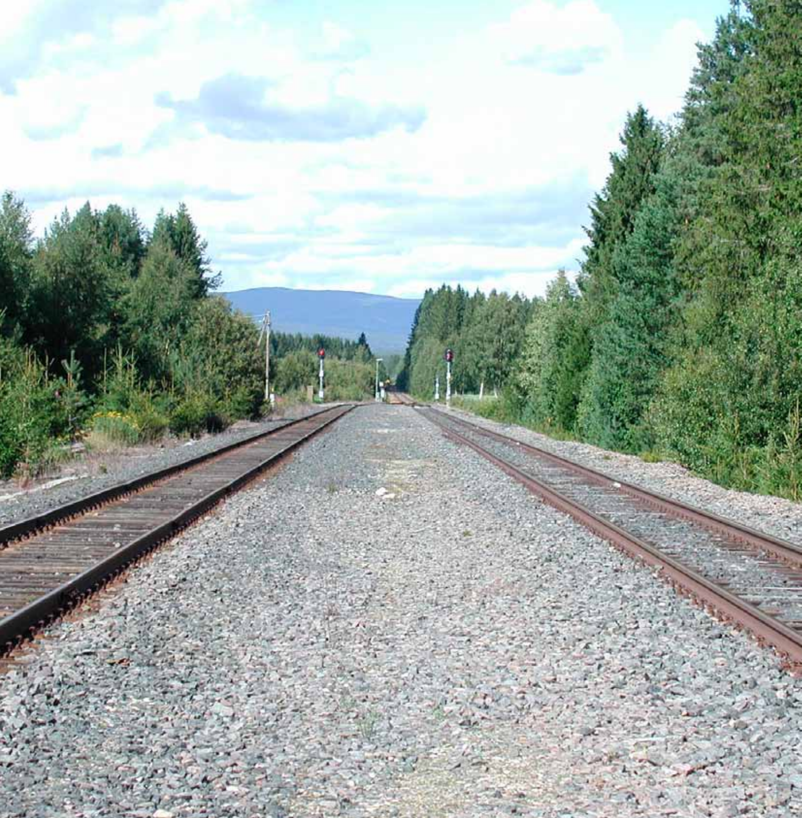
Rørosbanen. Foto: Sven Goll/Jernbaneverket
