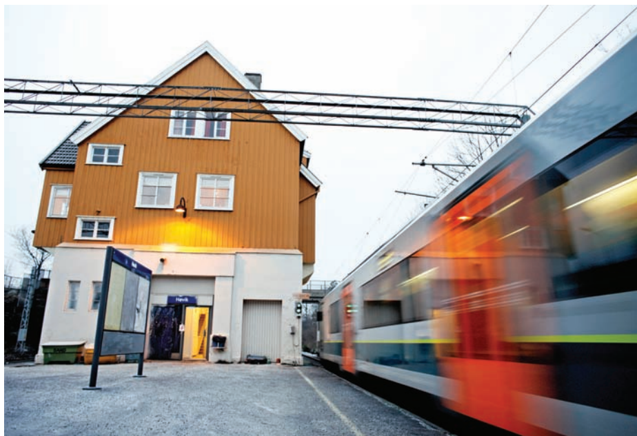
Stasjonsbygningen og gangbroen i bakgrunnen vil bli revet. (Foto: Hilde Lillejord)
