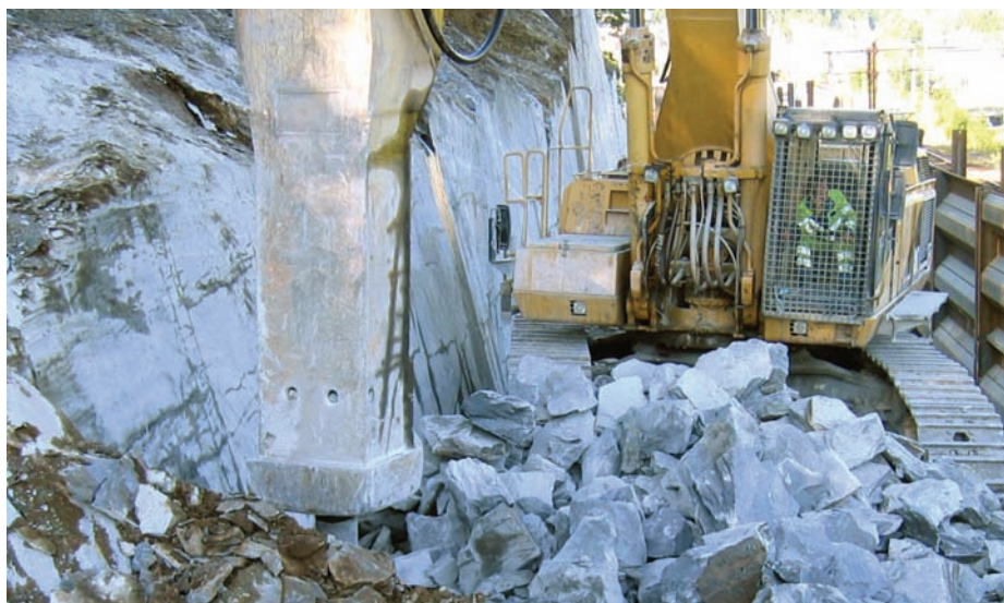
Arbeid med riving, sprengning og graving vil gi betydelige støyulemper. (Illustrasjonsfoto: Hilde Lillejord)
