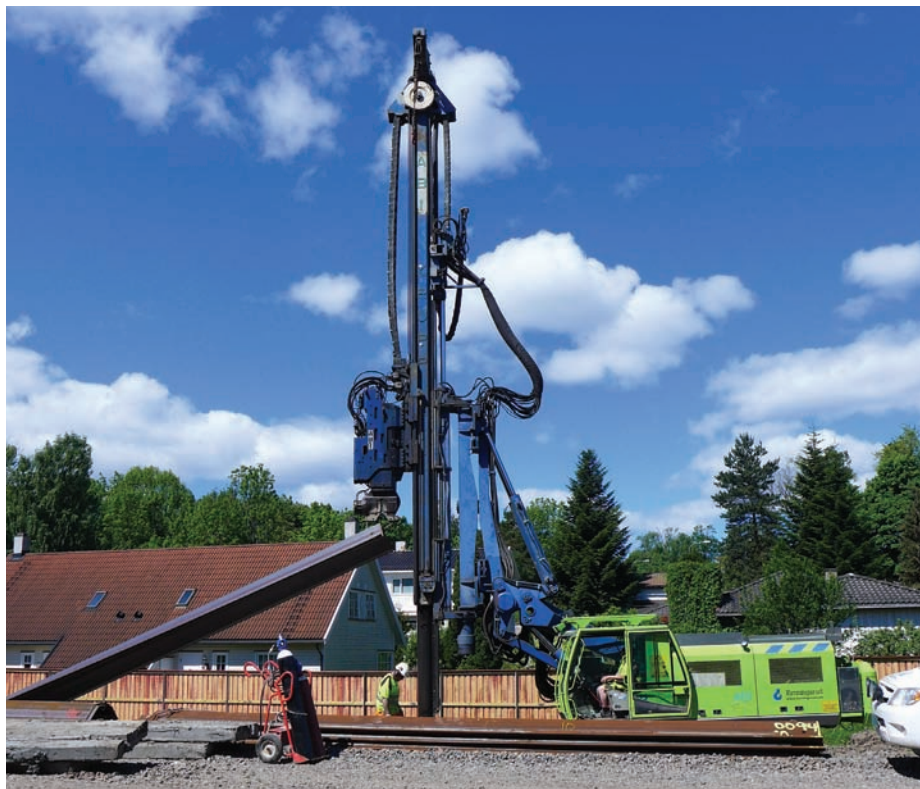
Denne maskinen presser spuntåler av stål ned i bakken. Spuntene danner en vegg som hindrer utglidning av massene.
